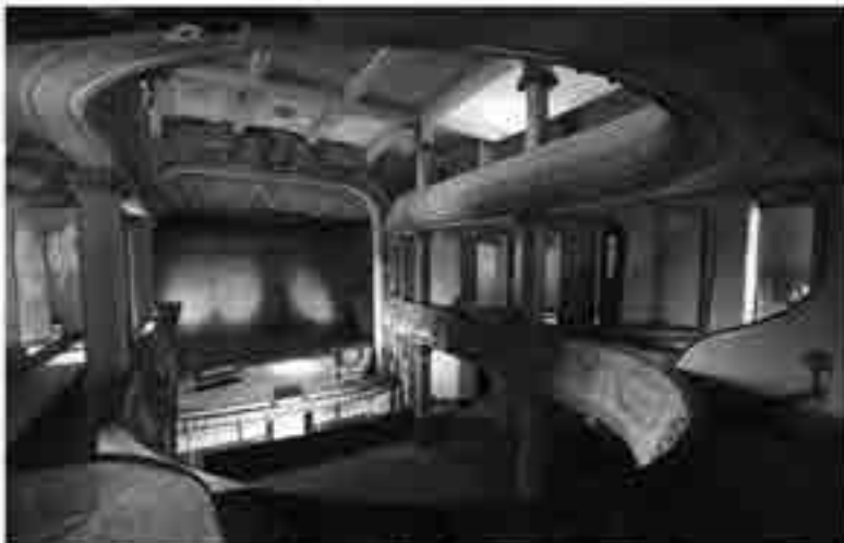
La sécurité et l'accessibilité sont placées en priorité pour la réhabilitation du théâtre. Photo Jean-Michel Fortinon
